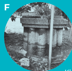
F Pozostałość po schodach prowadzących na promenadę wzdłuż Kanalu Kłodnickiego.
