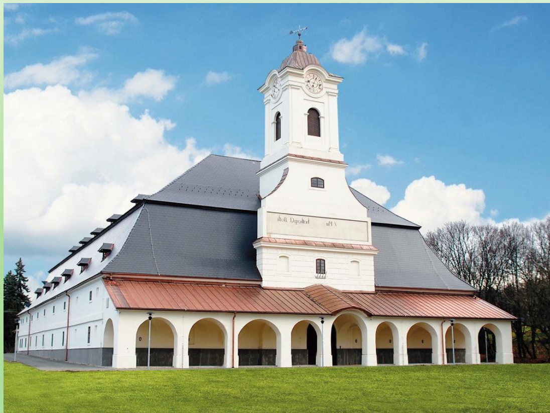
Budova solivaru v Prešove
